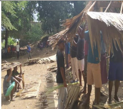
Gbr. 11. Proses pemasangan atap ( nuki )
