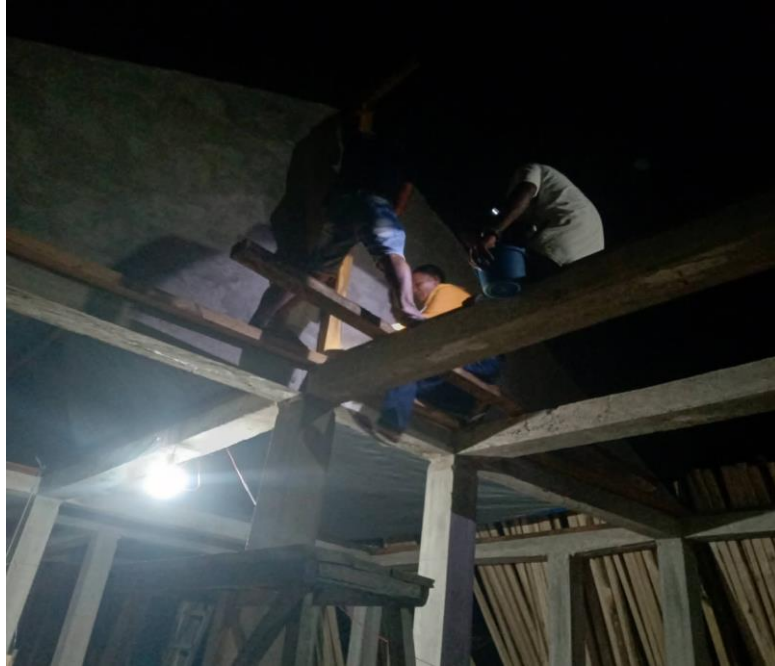
Gambar 5: Pemasangan Mangu ( Toka Mangu ) 2
