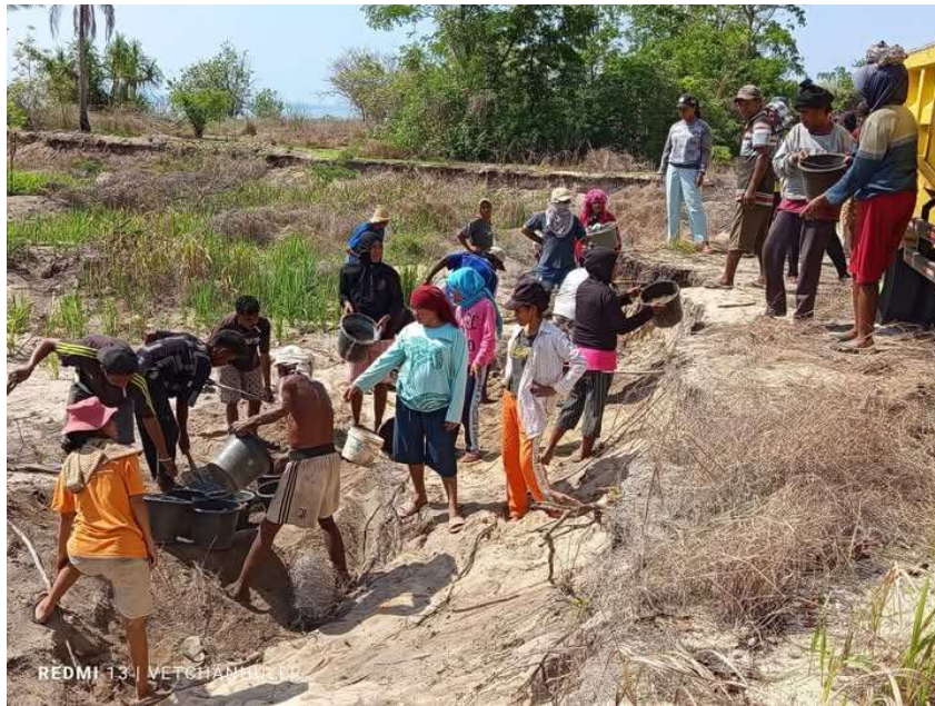
Gambar 4. Gemohing pengerjaan jalan desa.
