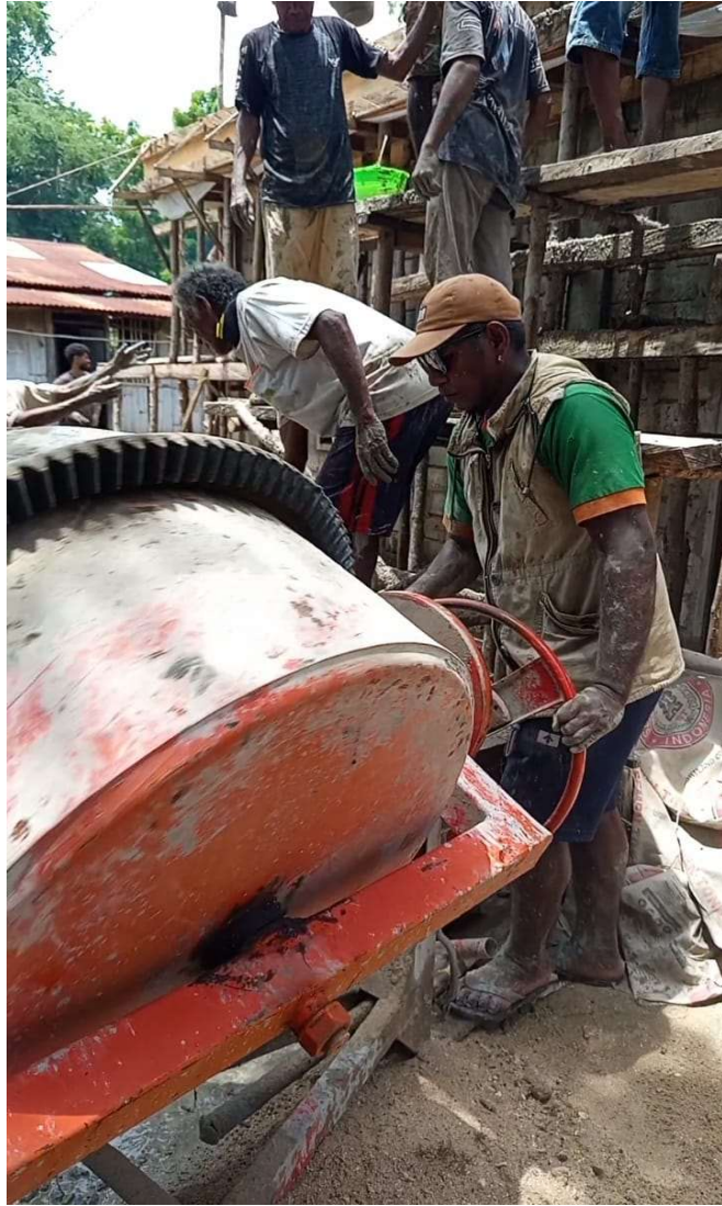
Gambar 5. Gemohing dalam pembangunan rumah.
