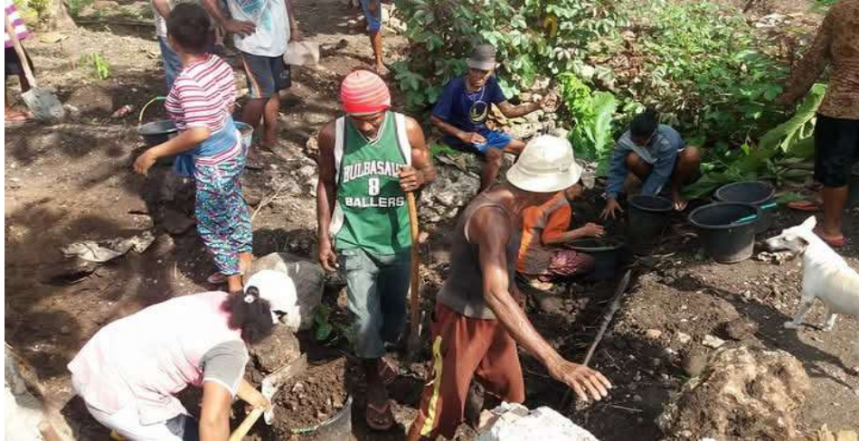
Gambar 6. Gemohing pengerjaan jalan desa.
