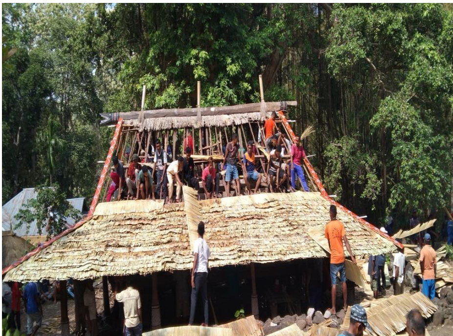
Gambar 12. Pemasangan Atap Koko
